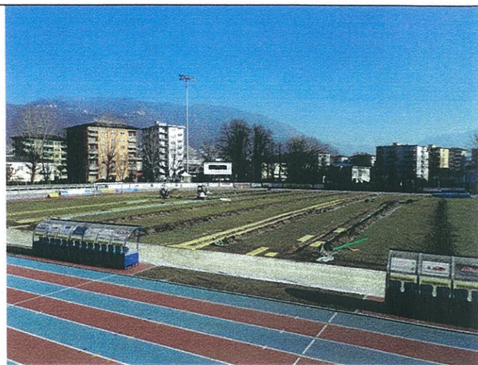
I lavori proseguono alacremente martedì 1 febbraio 2011 ore 12.00 ca.
