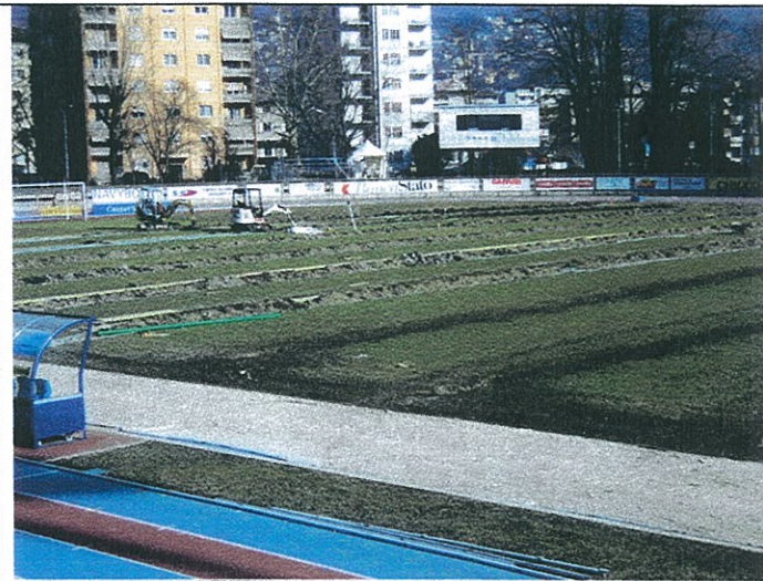
Ulteriore panoramica dei lavori stato 1/02/2011
