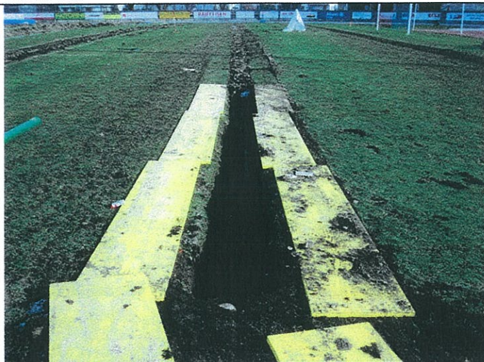
Domenica 23/01/2011 particolare degli scavi
